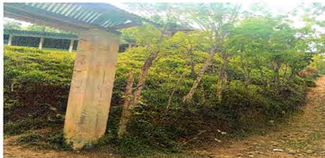
Foto 3: Sustrucion del cerco perimetral
