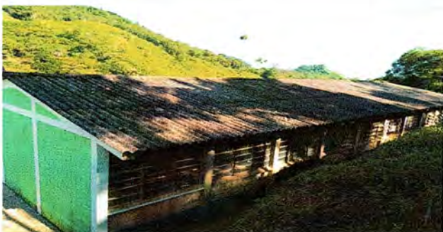
Foto 3: Sustrucion de techo
