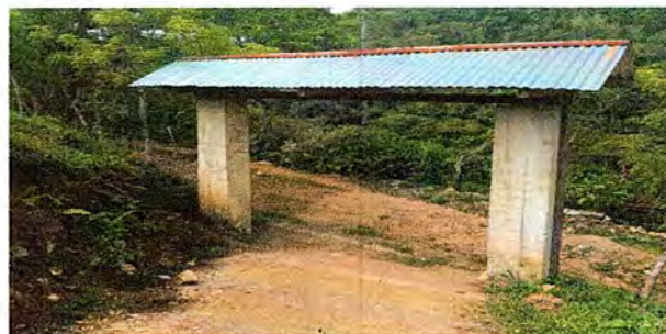
Foto 6: Colocacion de porton
