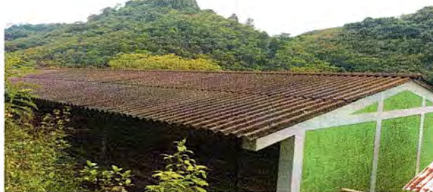
Foto 2: Edificio de tres Aulas
