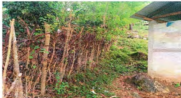
Foto 2: Parte del cerco perimetral al norte
